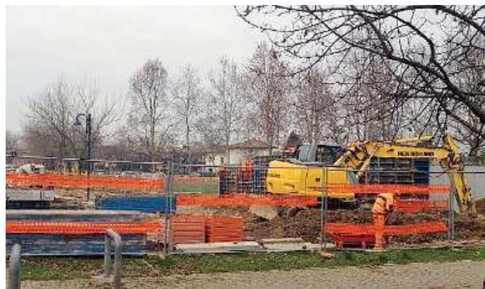
Cantiere. Al parco Cono Ottico i lavori procedono velocemente
