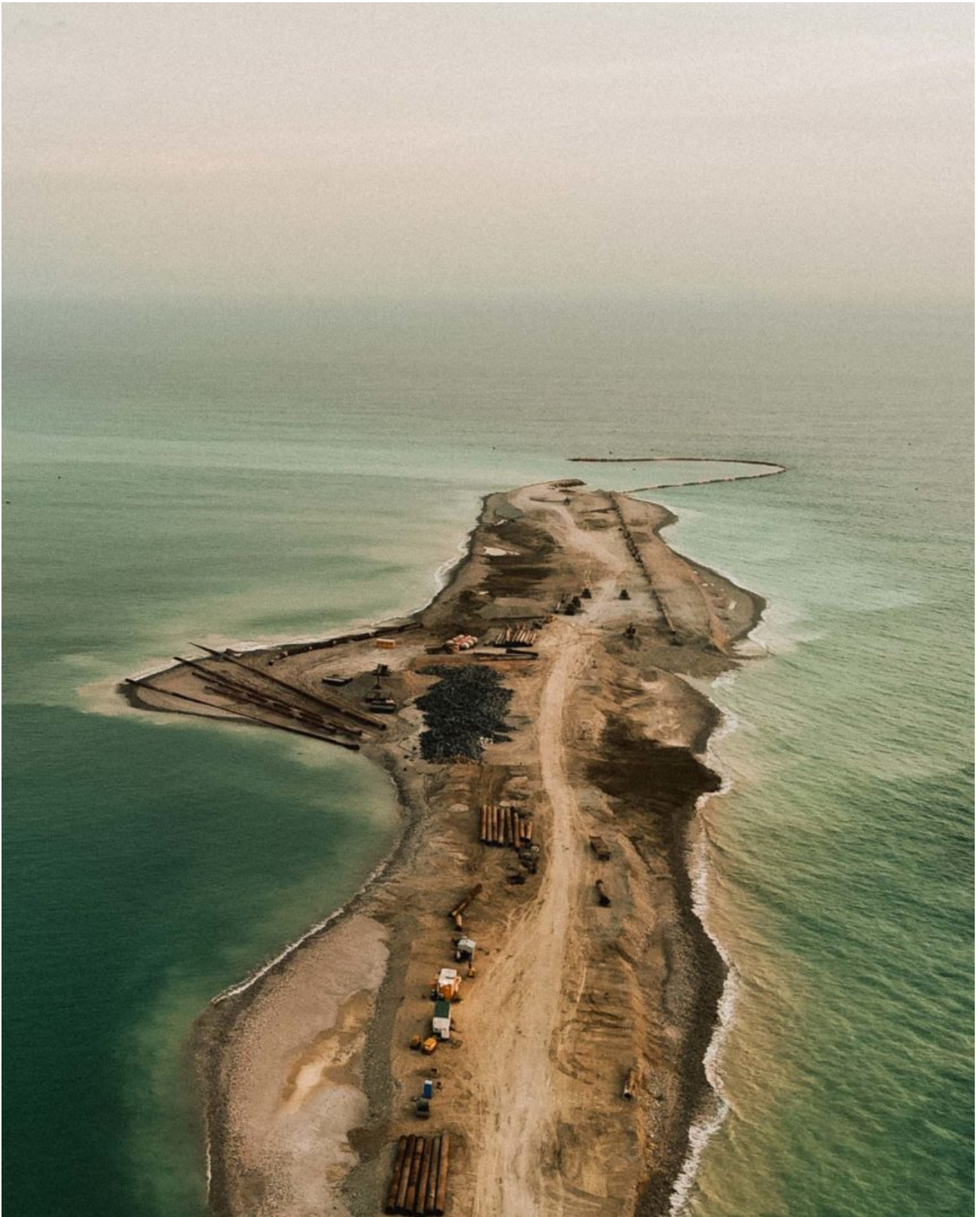
3. classificato Alessandro Murtas Nuovo porto in costruzione nei pressi di Ndayane
