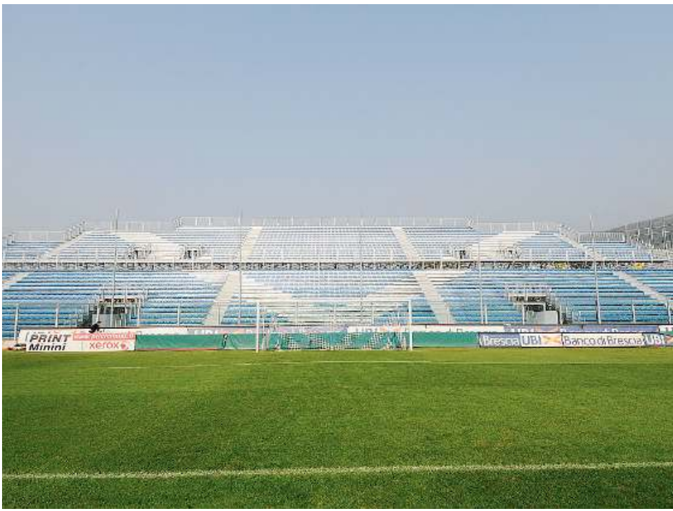
Rigamonti. Nel Pgt è inserita la ristrutturazione dell'impianto di Mompiano
