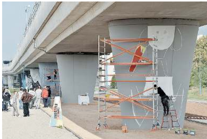
Al lavoro. Ponteggi allestiti e artisti all'opera sui piloni del metrò a Sanpolino
